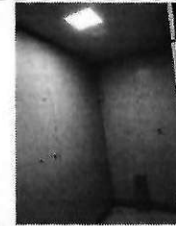
REVESTIMENTOS DOS BANHEIROS
