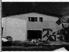
VISTA FRONTAL DA EDIFICAÇÃO COM ESQUADRIAS NOVAS, TEXTURA E PINTURA ARTÍSTICA
