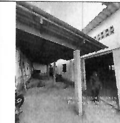
TELHAMENTO COM TELHA CERÂMICA
