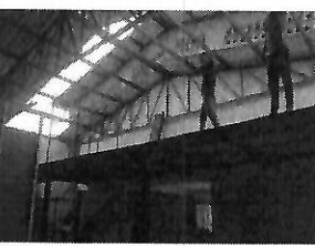
REMOÇÃO DE TELHAS PARA ELEVACÃO DA COBERTURA
